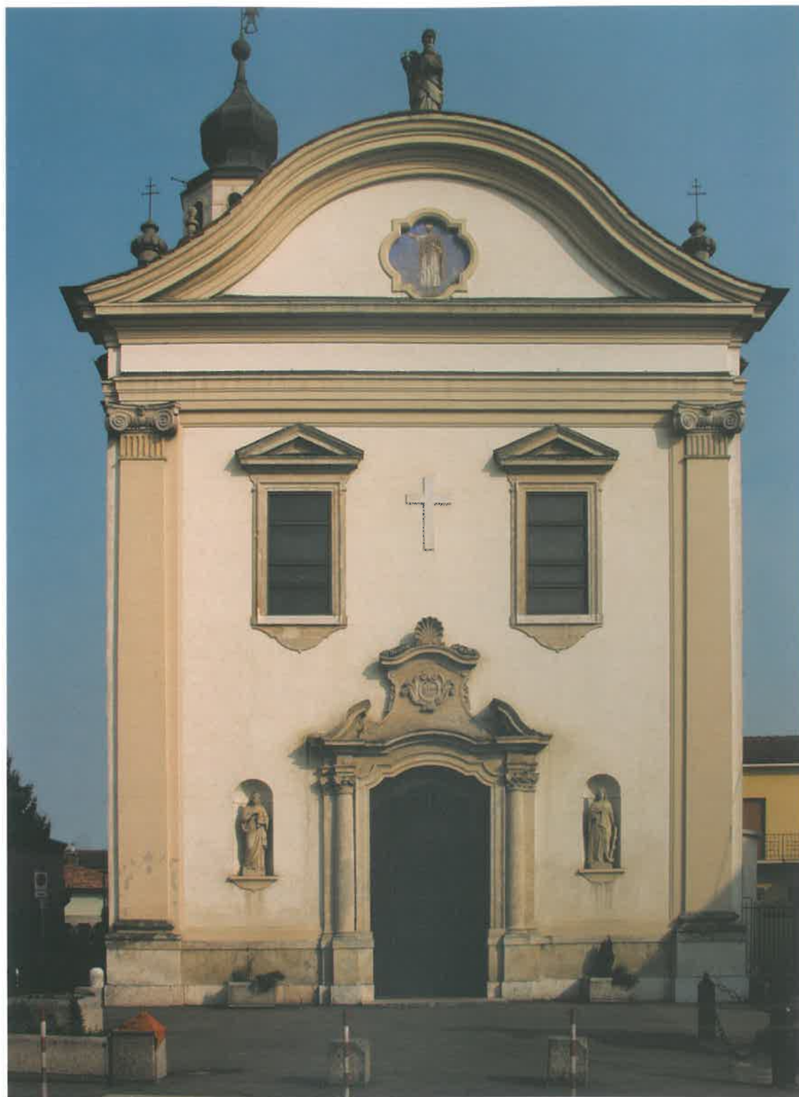
1. La facciata della chiesa parrocchiale di Mozzecane.
