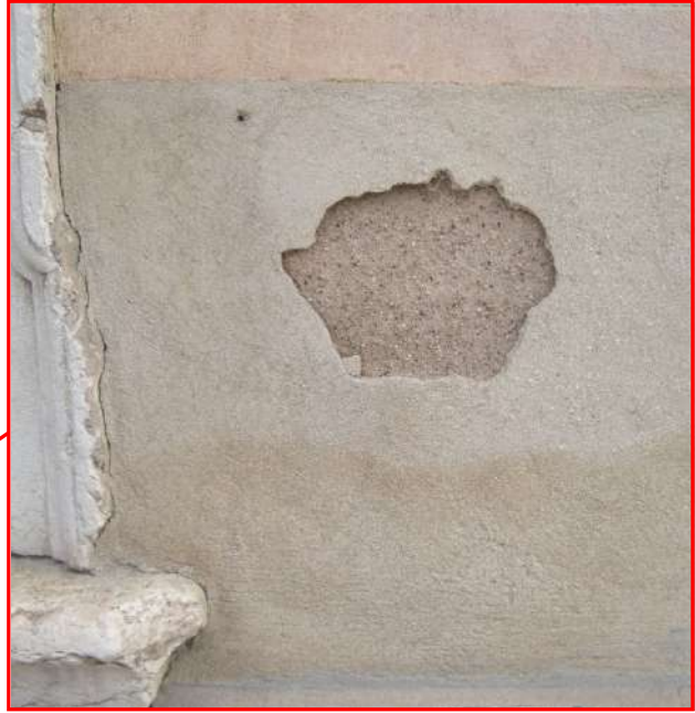
Distacco e disgregazione intonaco
