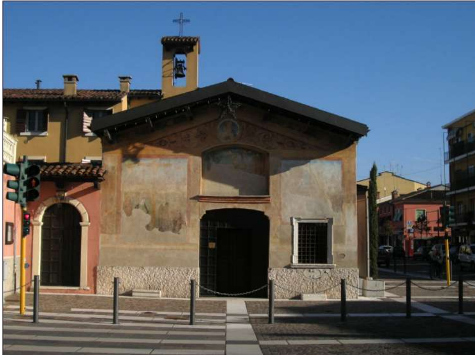
Visone totale facciata
