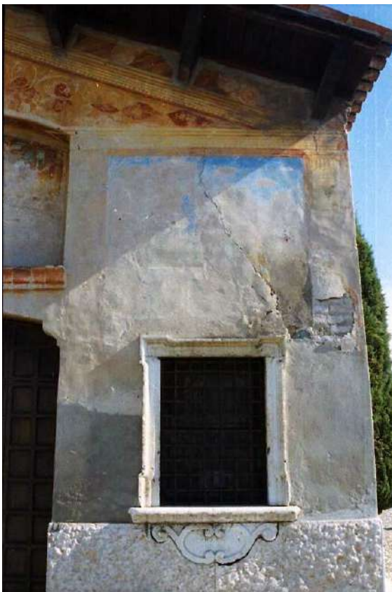
Fessurazione sull'affresco sopra alla finestra, a sinistra prima dell'intervento e a destra stato attuale
