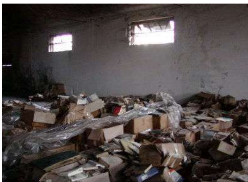
Foto del padiglione 24 dopo l'incendio
