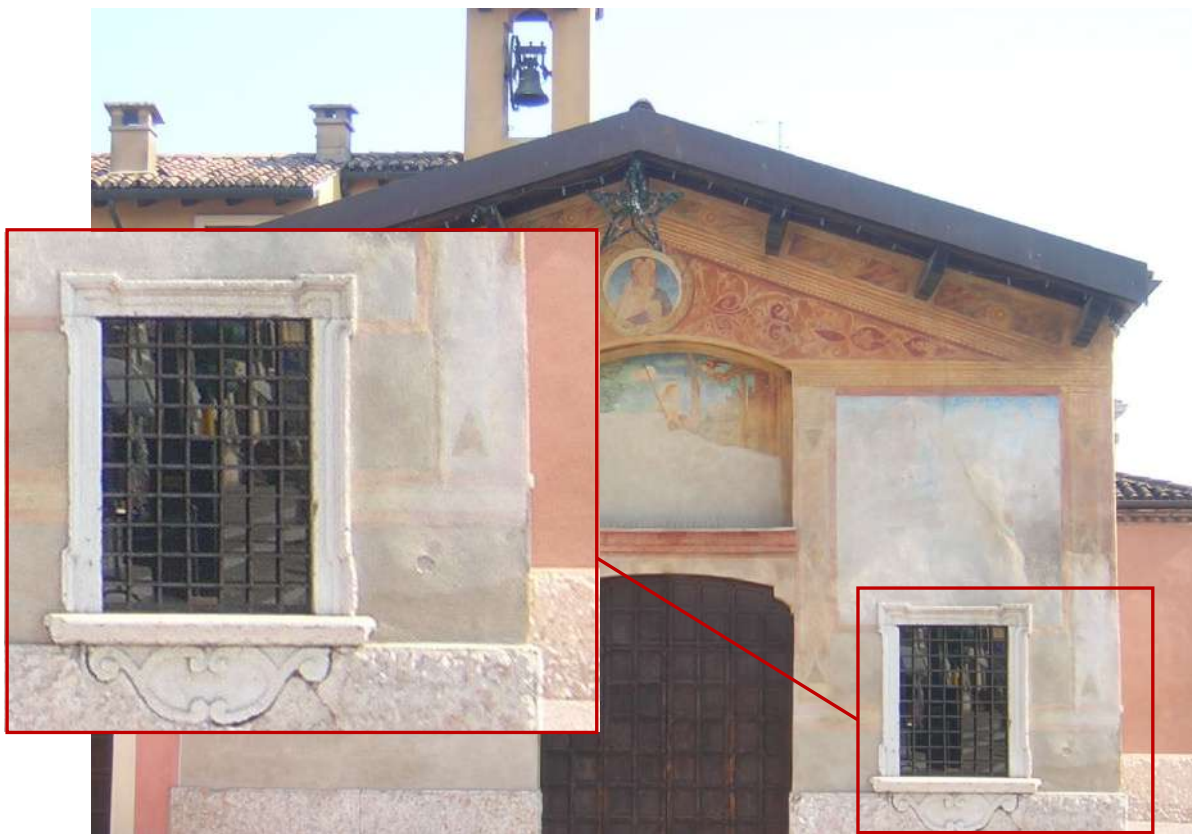
Distacco e disgregazione intonaco
