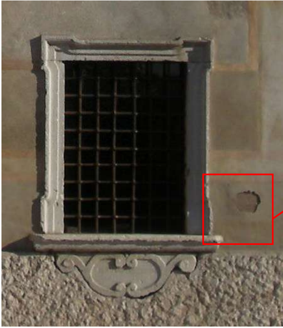
Distacco e disgregazione intonaco
