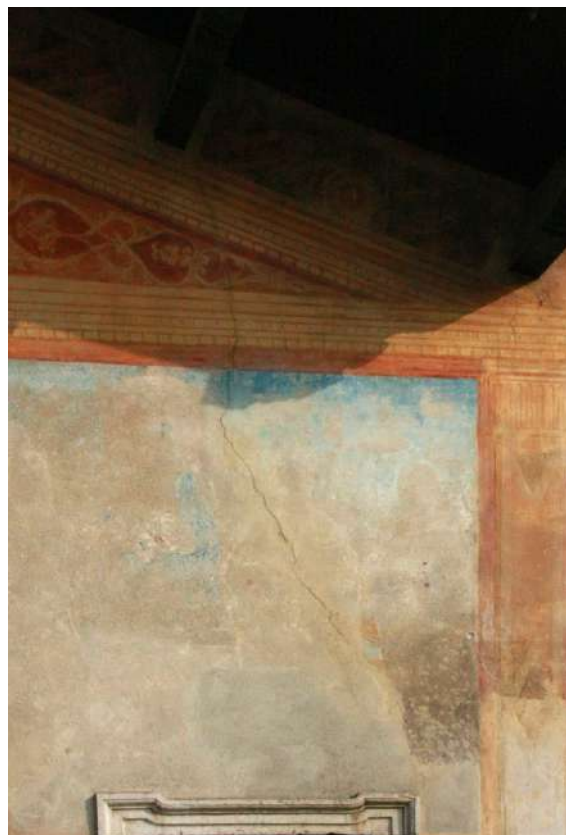
Fessurazione sull'affresco sopra alla finestra, a sinistra prima dell'intervento e a destra stato attuale
