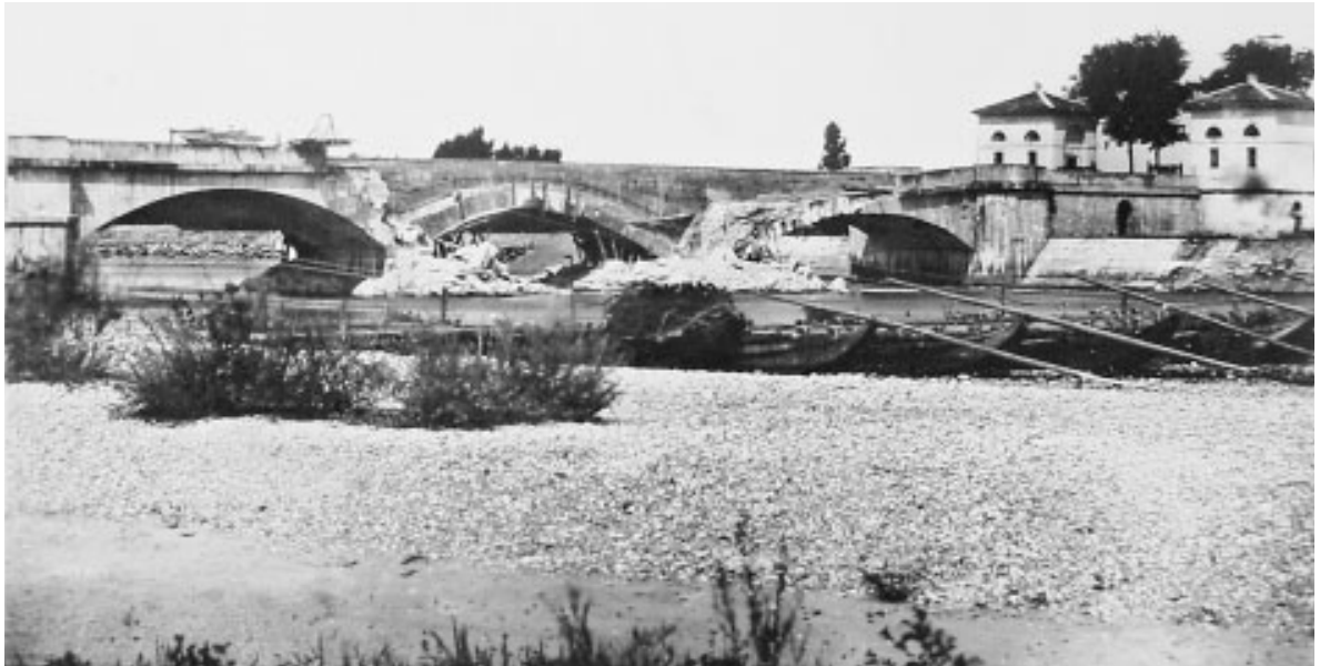
Visione dei danni al Ponte Nuovo di Magenta. In primo piano sulla riva del Ticino alcune barche-pon-toni che formano un ponte provvisorio per passaggio delle truppe. (Foto di autore ignoto, per uso stereografico, 1859).
