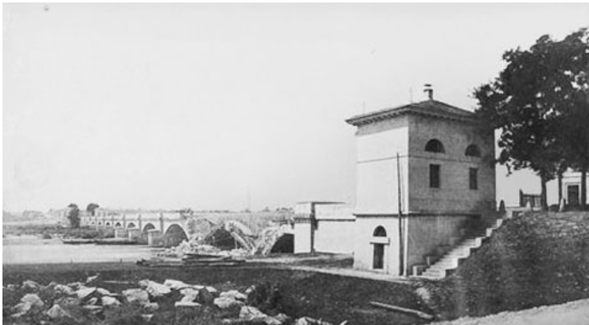
Il ponte nuovo di Magenta visto dal lato austriaco. Le ultime due arcate sono danneggiate nel tentativo di farle saltare. Le due costruzioni ai lati servivano come posto di dogana. (Foto di L. Méhédin, 1859).
